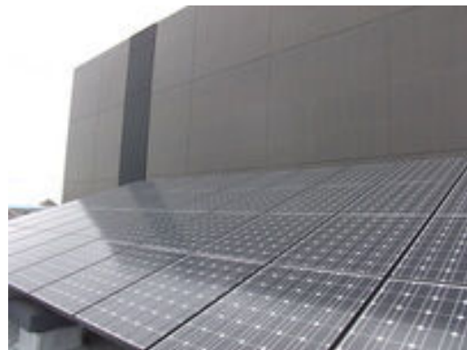
メロープラザの屋上
